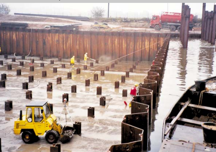
Fot. 6. Oczyszczalnia ścieków
