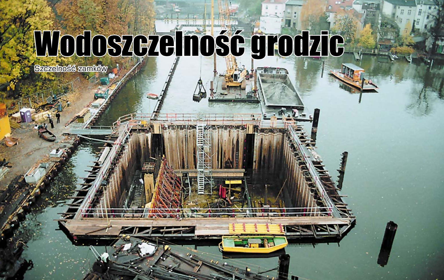
Fot. 1. Budowa śluzy Spandau, Niemcy
