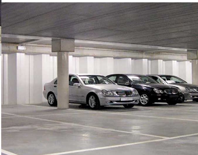
Fot. 5. Parking podziemny
