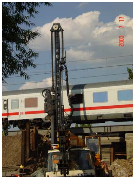
Zdjęcie nr 6. Pograżanie grodzic .Most kolejowy w Lewinie Brzeskim
