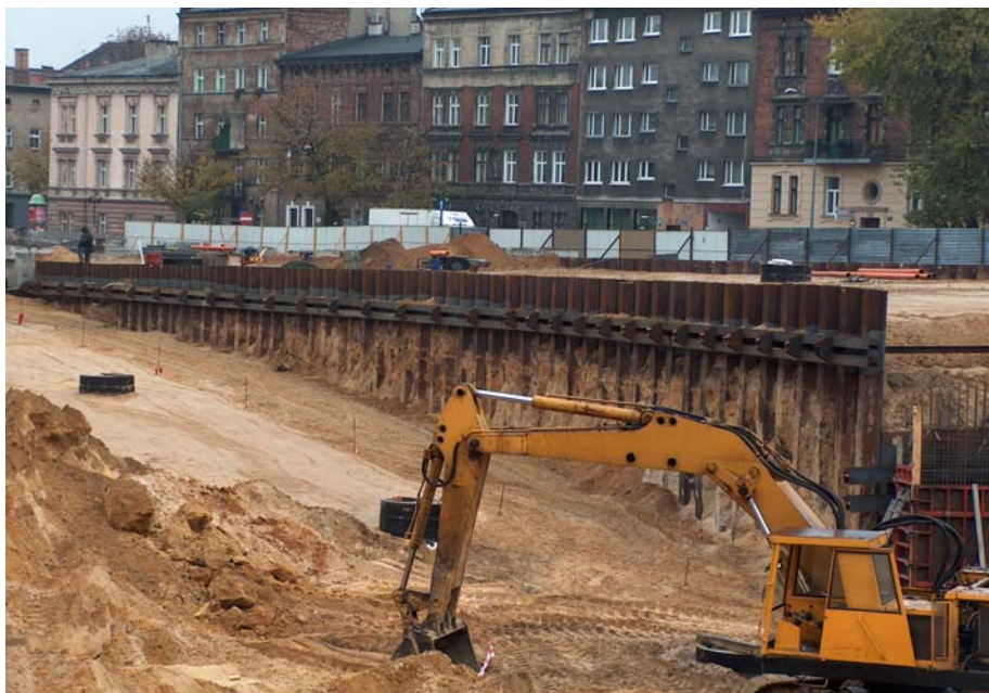
Zdjęcie nr 5. Wiadukt Trasy Galicyjskiej w Krakowie .
