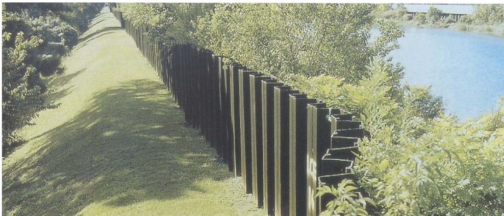
Zdjęcie nr 11. Grodzice jako wzmocnienie wału przeciwpowodziowego .
