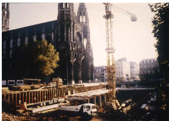
Zdjęcie nr 7. Budowa parkingu podziemnego w Rouen . Francja
