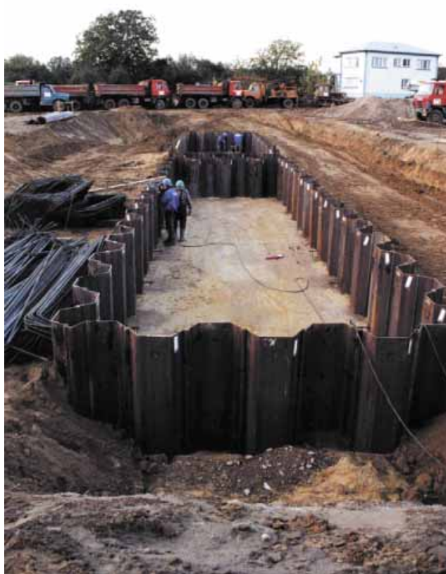
Fot. 2. Komory z PU 16 - most Siekierkowski Warszawa
