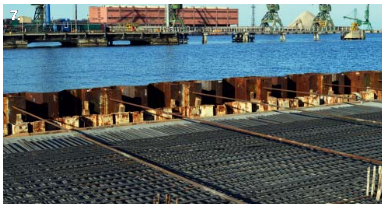
Fot. 1. Konstrukcja ściany Nabrzeża Szwedzkiego (marzec 2014) Fot. 2. Sprefabrykowane „skrzynki” z profili HZ na placu składowym Fot. 3. Profile wypełniające AZ przed przygotowaniem do pogrążenia Fot. 4. Podnoszenie dwupoziomowej ramy prowadzącej Fot. 5. Prace konstrukcyjne w sekcji I nabrzeża Fot. 6. Zakotwienie ściany HZ/AZ Fot. 7. Płyta nabrzeża przygotowana od betonowania - w tle Nabrzeże Holenderskie
