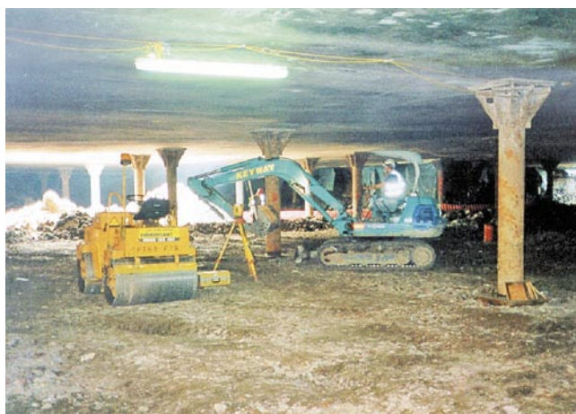
Fot. 3. Budowa parkingu metodą stropową, Bristol, Wielka Brytania
