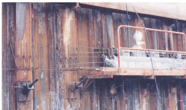
Fot. 4. Żelbetowy wspornik do oparcia prefabrykowanego stropu
