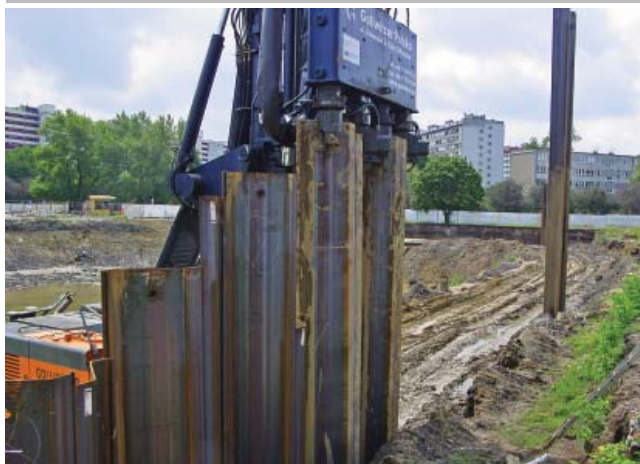
Fot. 6. Urządzenie do statycznego wciskania grodzic na budowie SkyTower
