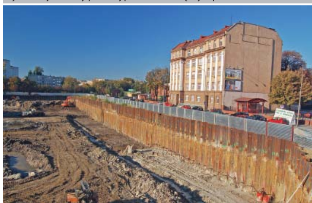
Fot. 2. Obudowa wykopu z grodzic AZ20-700 wzdłuż ul. Gwiaździstej. Po prawej widoczny budynek szpitala.
