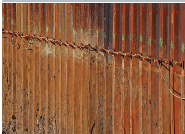
Fot. 4. Pierwszy rząd kotew gruntowych
