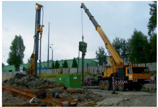
Fot. 4. | Trudne warunki wymagały podwiercania gruntu
