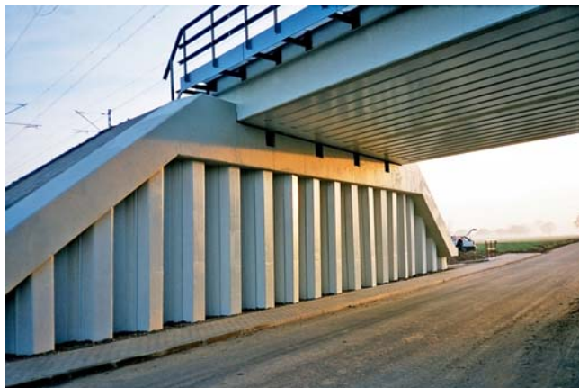
Fot. 2. Przyczółki wiaduktu kolejowego w Lewinie Brzeskim. Dzięki zastosowaniu rozwiązania opartego na grodzicach linia kolejowa została zamknięta jedynie na 36 godzin
