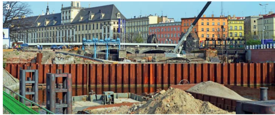
Fot. 1. Jaz Wrocław I – widok z mostu Sikorskiego Fot. 2. Jaz Wrocław I – grodza jazu Fot. 3. Jaz Wrocław I – widok od strony WD
