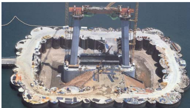
Fot. 2. Obudowa wykopu, Most Seo-Hae, Korea Południowa
