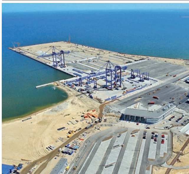
Fot. 3. Nabrzeża z grodzicę Arcelor Mittal, budowa DCT, generalny wykonawca – Hochtief
