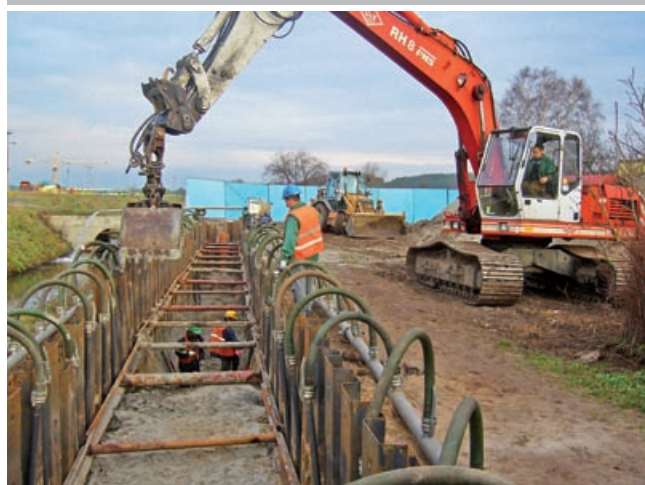
Fot. 6. Grodzice zimnogięte jako obudowa wykopu liniowego przy budowie kanalizacji, Dębogórze Wybudowanie, generalny wykonawca – firma Wodjar
