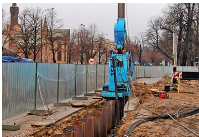
Fot. 5. Urządzenie do statycznego wciskania grodzic marki Giken, budowa Centrum Haffnera w Sopocie, pogrążanie grodzic – Aarsleff Sp. z o.o.
