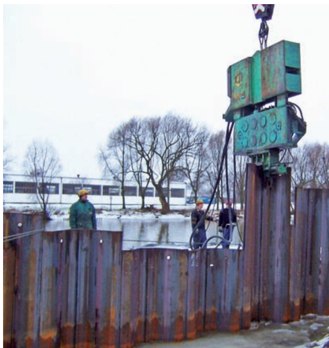
Fot. 2. Grodzicę AZ17-700 na budowie nabrzeża w Elblągu, generalny wykonawca – Navimor Invest
